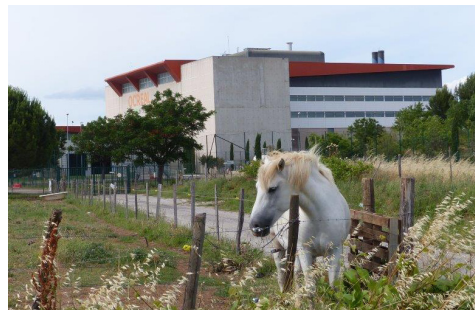
L'usine d'incinération de Lunel-Viel. Pas si bucolique qu'elle en a l'air.
