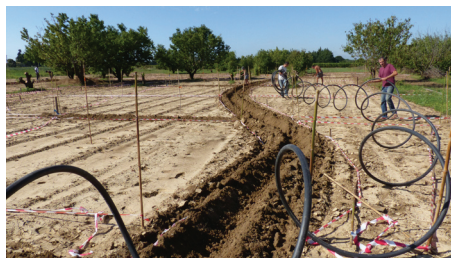
Un moment de convivialité, la pose des tuyaux
