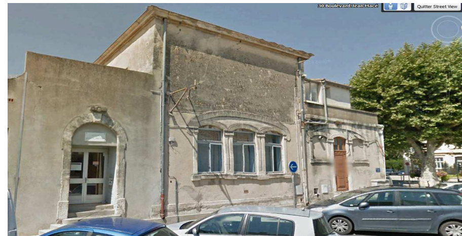
Ancienne école de filles, mur latéral est, boulevard Jean Macé
